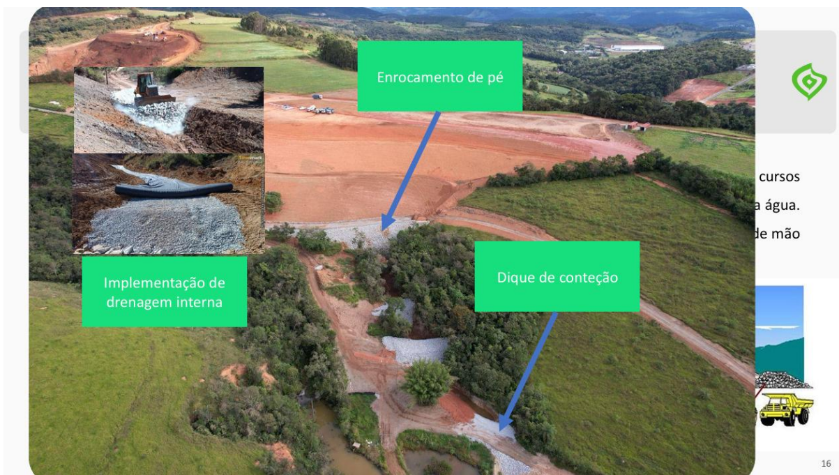
Figura 5 – Slide da apresentação institucional do Projeto Ivoti indicando estruturas de "Enrocamento de pé", "Dique de contenção" e "Implementação de drenagem interna", não identificadas nos documentos do licenciamento ambiental.
